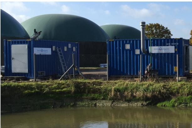
Der Bioreaktor ist so aufgebaut, dass er durch Abwärme beheizt werden kann. Hiermit ist sichergestellt, dass auch während längerer Kälteperioden die optimale Betriebstemperatur für die Mikroorganismen gehalten wird.
