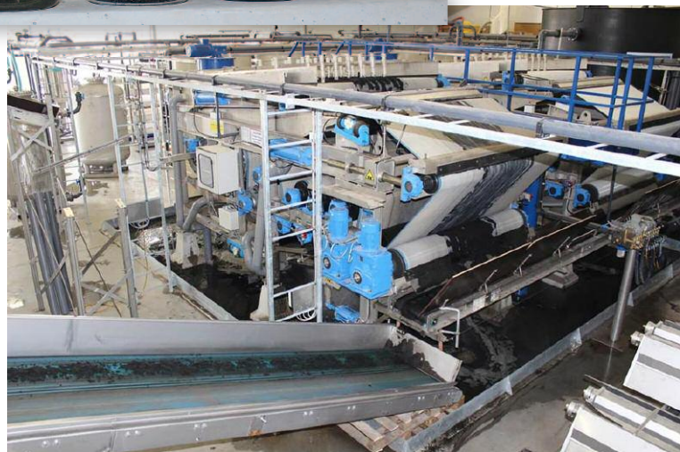
In der Kumac-Anlage werden Gülle und Gärrest in vier Schritten aufbereitet: Flotationsbecken, Separation, Siebbandpresse, Umkehrosmose. Werksfotos
